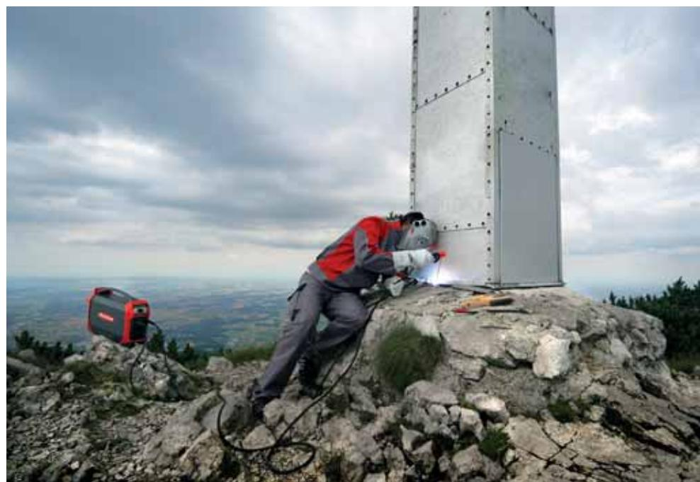
Obr. 2 Zvárací systém MMA s akumulátorom AccuPocket 150/400 od spoločnosti Fronius umožňuje ručné zváranie a zváranie TIG nezávislé od siete.
