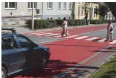
Obr. 10 Brzdaci úsek z gumového granulátu
